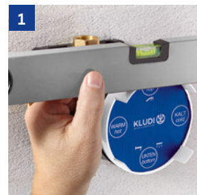
Upevnenie podomietkového telesa.
