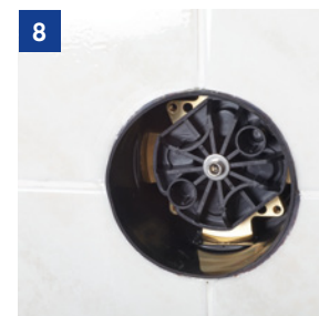
Odstránenie preplachovacieho modulu.
