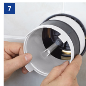
Vytiahnutie plastového prvku pláštá.
